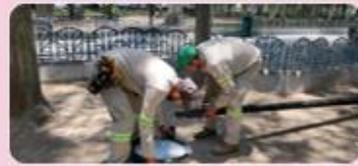
Instalación de 75 postes y 75 luminarias por personal de Alumbrado Publico, realizando las cepas para soportes y la instalación eléctrica.
